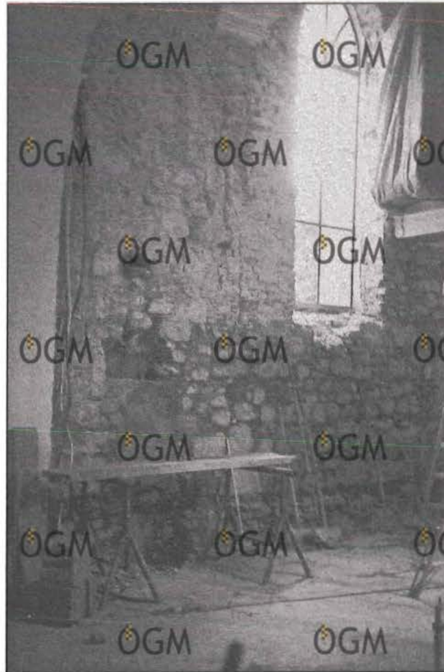
Abb. 11: Attersee, Martinskirche. Südmauer des Langhauses (von links nach rechts: Triumphbogen verputzt, Abzugloch eines Kachelofens, Baunaht einer ehemaligen Fensteröffnung). (Photo: August MAYER).
