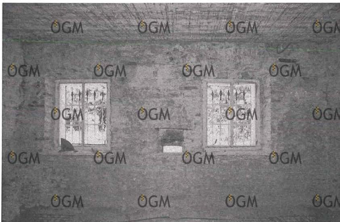
Abb. 4: Perschlinghof, KG Fahrafeld. Raum 3: Westwand mit spätmittelalterlichem Putz und Lichtscharte. (Photo: K. Kühnreiter).
