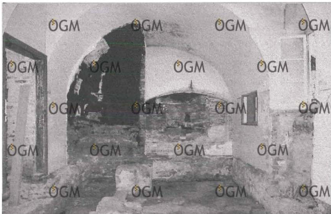
Abb. 9: Perschlinghof, KG Fahrafeld. Küche (Raum 2) Richtung Süden: Zuunterst Bodenpflaster und Eingangssituation von Phase 2 und 3, darüber der jüngste Backofen aus Ziegeln mit Kamin und danebenliegende Wandnische, die die Verbindung zum Kachelofen der Stube (Raum 1) bildete. (Photo: K. Kühtreiber).
