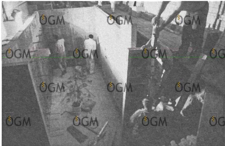
Abb. 3: Dom von St. Stephan in Wien. Einbau einer Betonwanne für das Heizaggregat im Jahre 2000. (Foto: J. OFFENBERGER, BDA).
