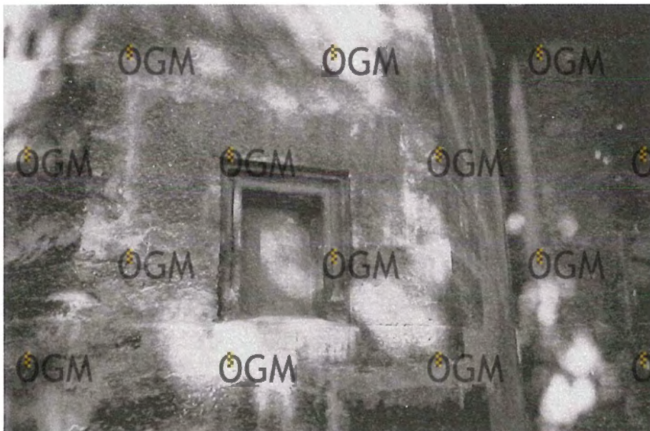
Abb. 2: Eggenburger Stadtpfarrkirche, Niederösterreich. Modellfenster an der Südfront des Westwerks. Das Modellfenster, ein Blindfenster in Augenhöhe, enthält in englischem Zoll gearbeitet alle Kleinmaße für das Maßwerk so, dass die Steinmetzen hievon Naturmaß nehmen konnten und sich danach Leeren und Schablonen anfertigen konnten. Englischer Zoll = 2,54 cm - vgl. Gotik. (Befund u. Zeichnung: Franz PERSCHL).
